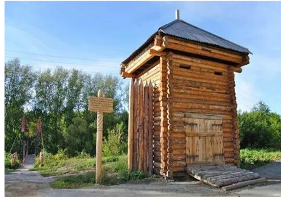
Реконструкция башни Ирбитского острога.
